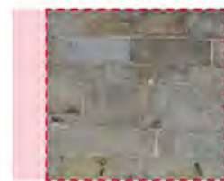
Parement en pierre de taille hauteur d'assise alternée (Renaissance)
