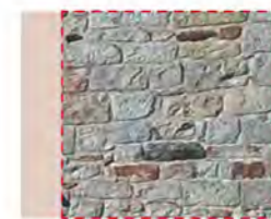
Parement pierres équarries en moyen appareil irrégulier hauteur d'assise variable (période non identifiée)
