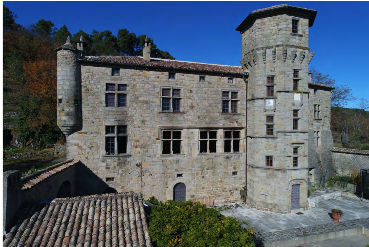
PC7 / DP5 & DP7 Environnement Proche
