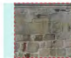
Parement en pierre de taille gros appareil (campagne de construction 1974)
